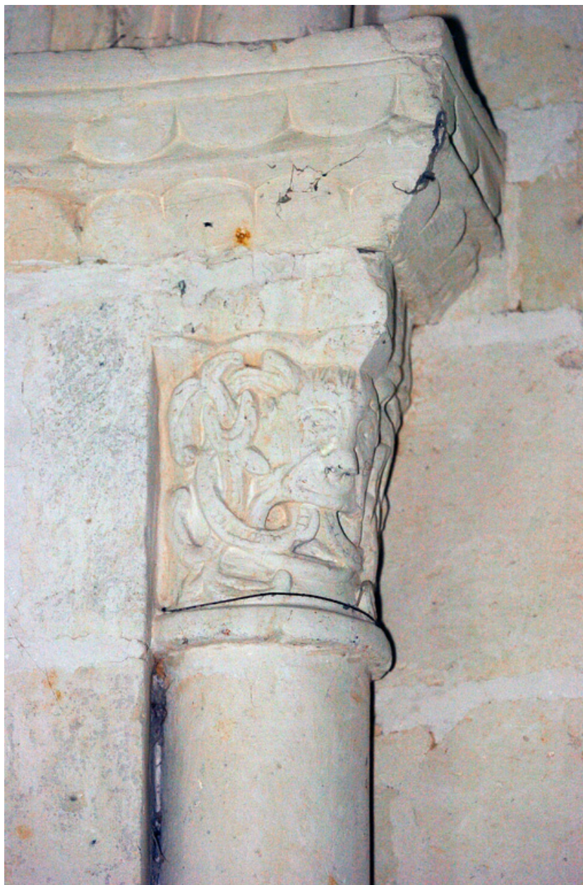
Abside, baie 2 : chapiteau gauche.
