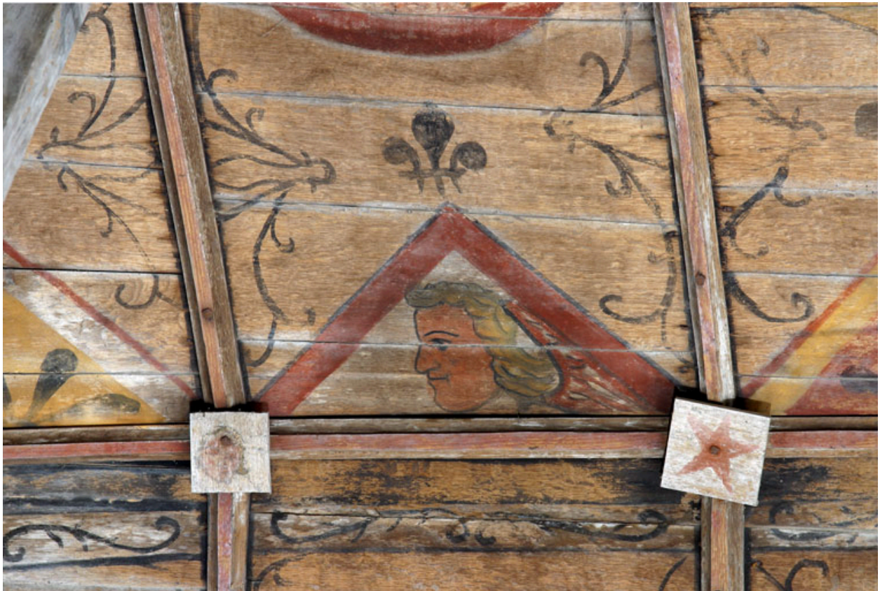
Nef, voûte, côté sud, première travée, registre de faîte : ange de profil.
