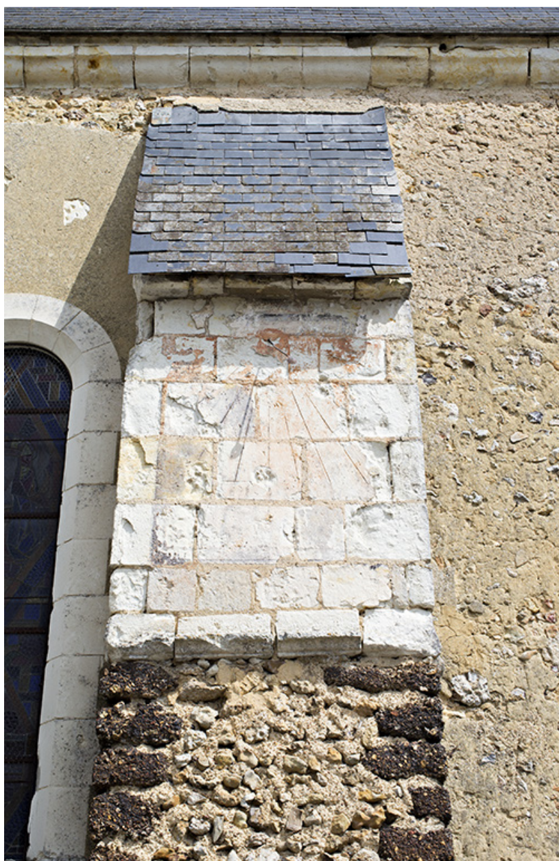
Mur sud de la nef : vestiges d'un cadran solaire sur la partie supérieure du contrefort.
