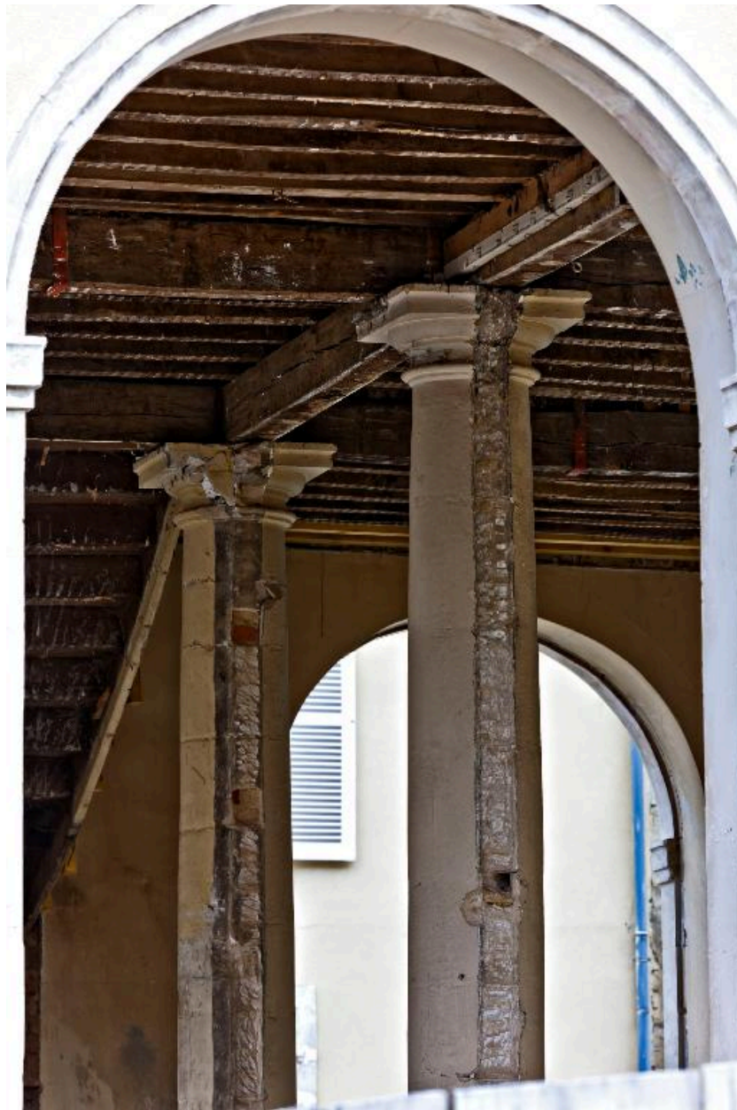
Colonnes subsistantes de la campagne de construction de 1854-1856.
