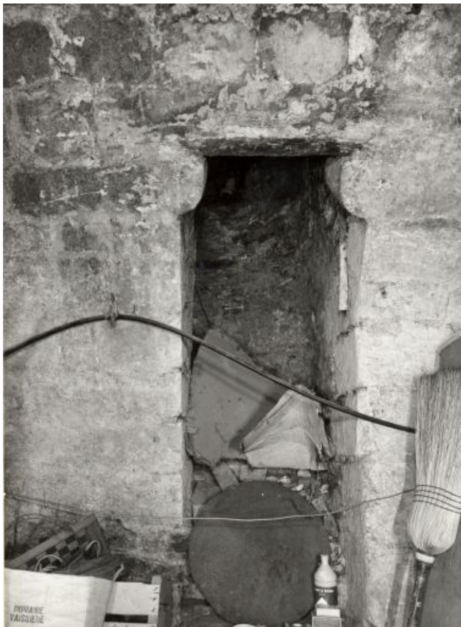
Logis postérieur, sous-sol, mur gauche : départ d'escalier.
