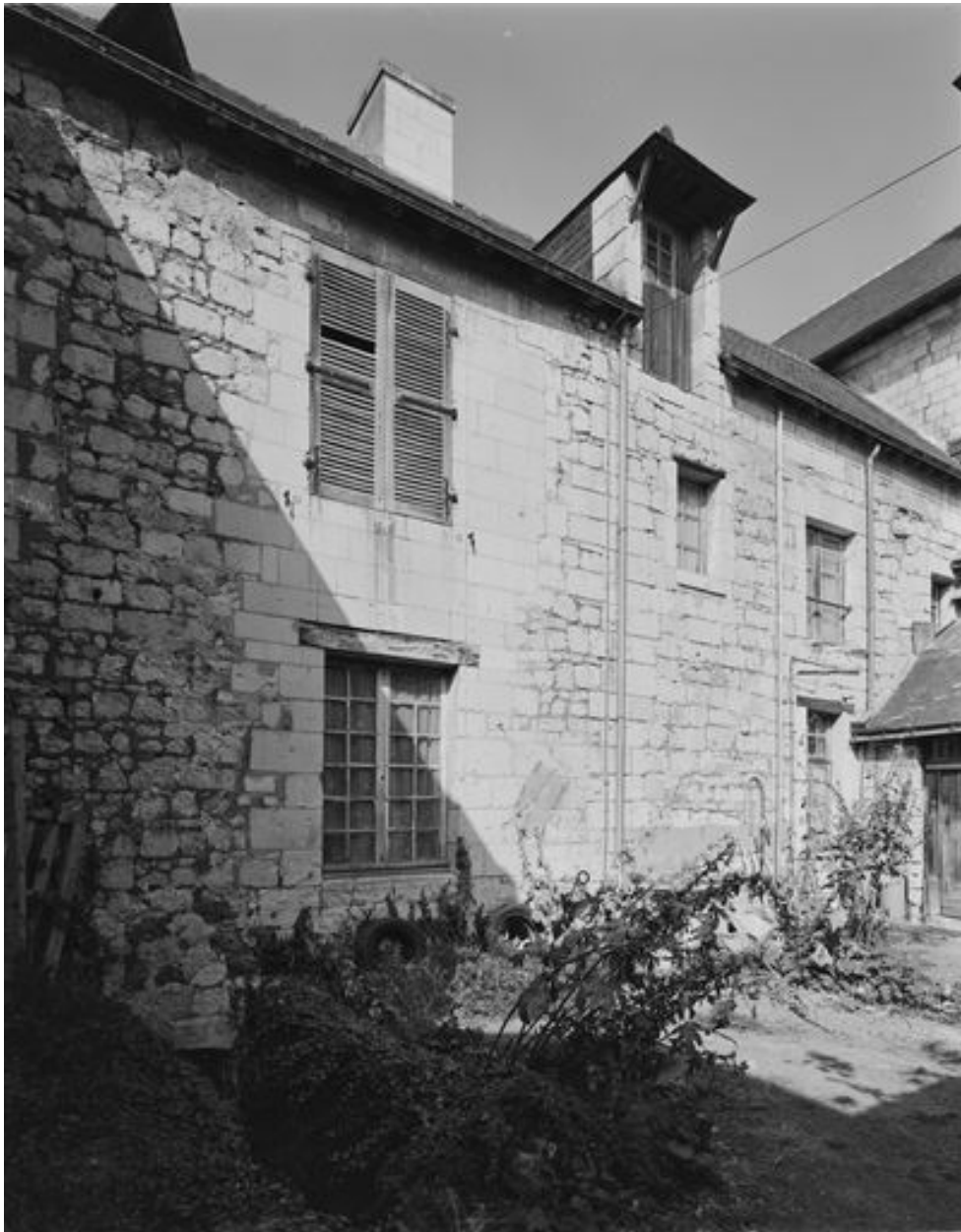
Détail de la façade postérieure, avant restauration (en 1996).
