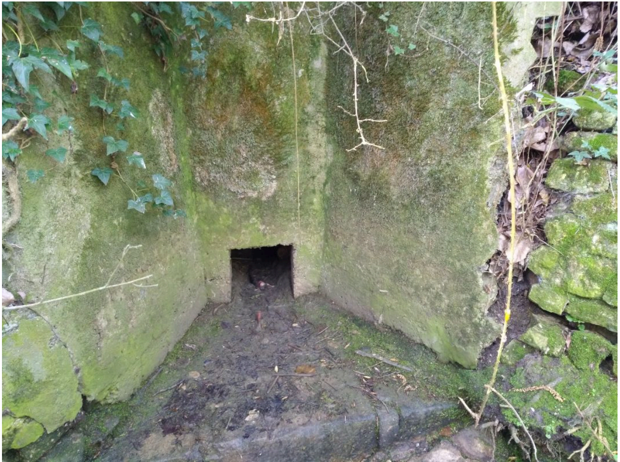
La bonde côté amont, au nord.
