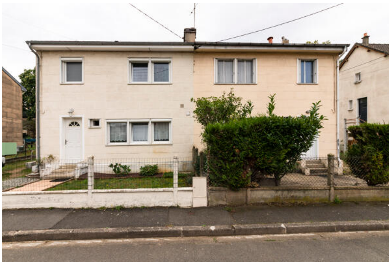
Vue de pavillons jumeaux, cité du Gibet.
