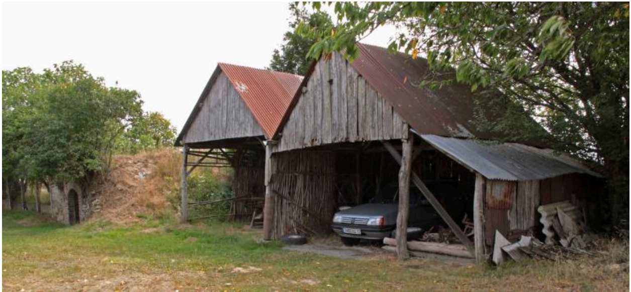
Petits hangars 2 et 3 : façades antérieures.
