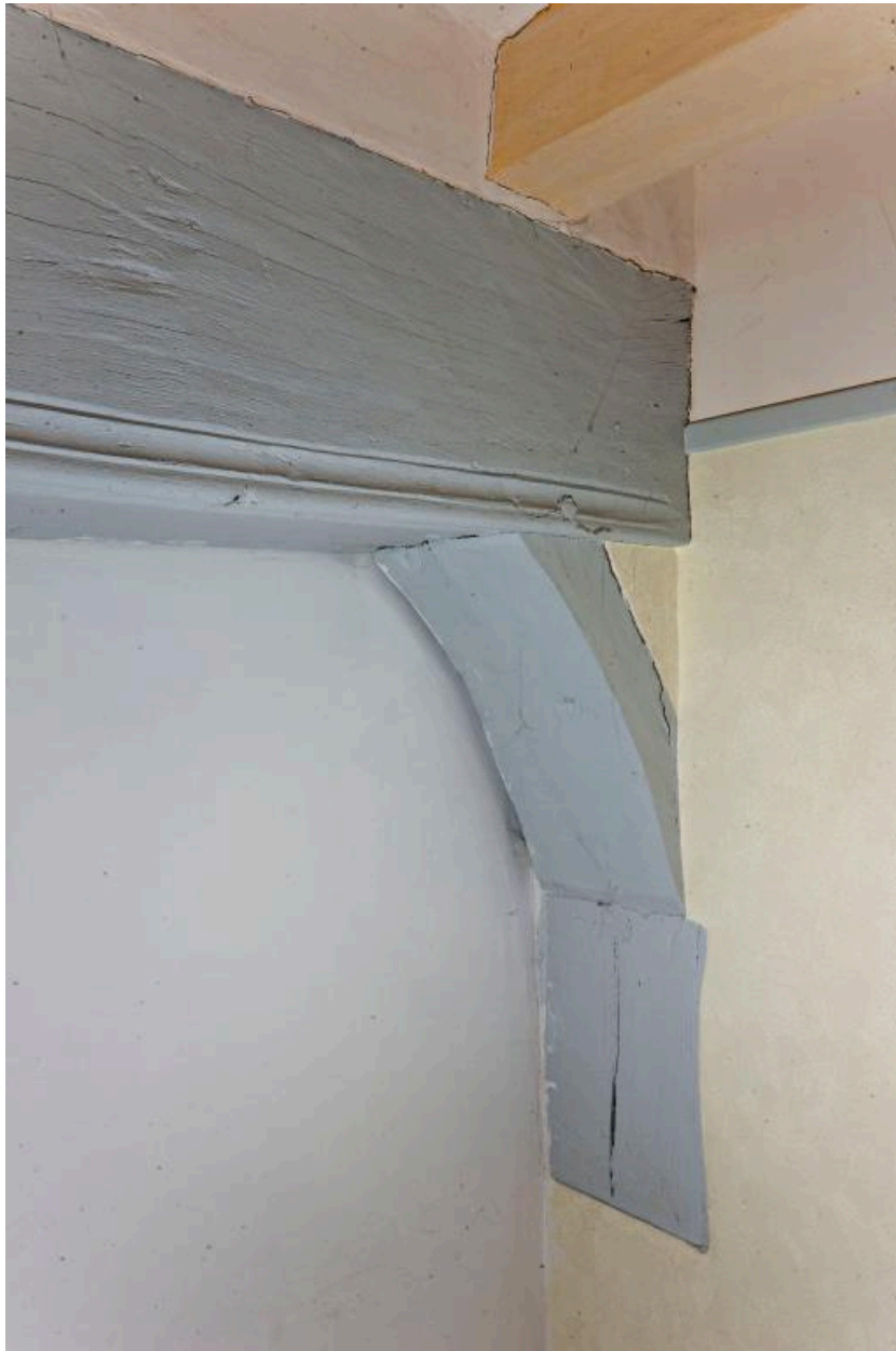
Maison du Pilier Vert, étage : poteau de bois dans la maçonnerie et poutre moulurée (détail).
