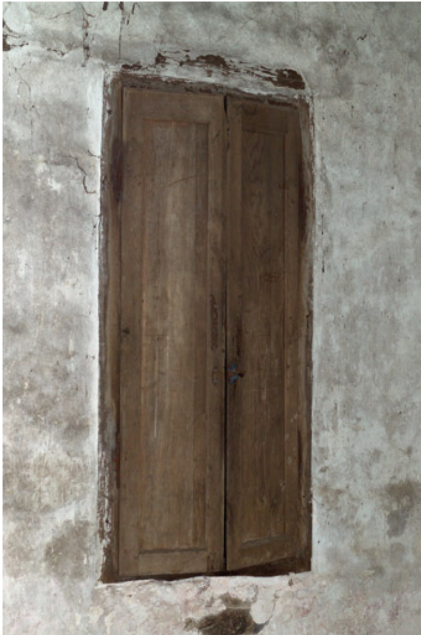
Aile sud, pièce orientale, premier étage, mur nord, détail de l'armoire murale.
