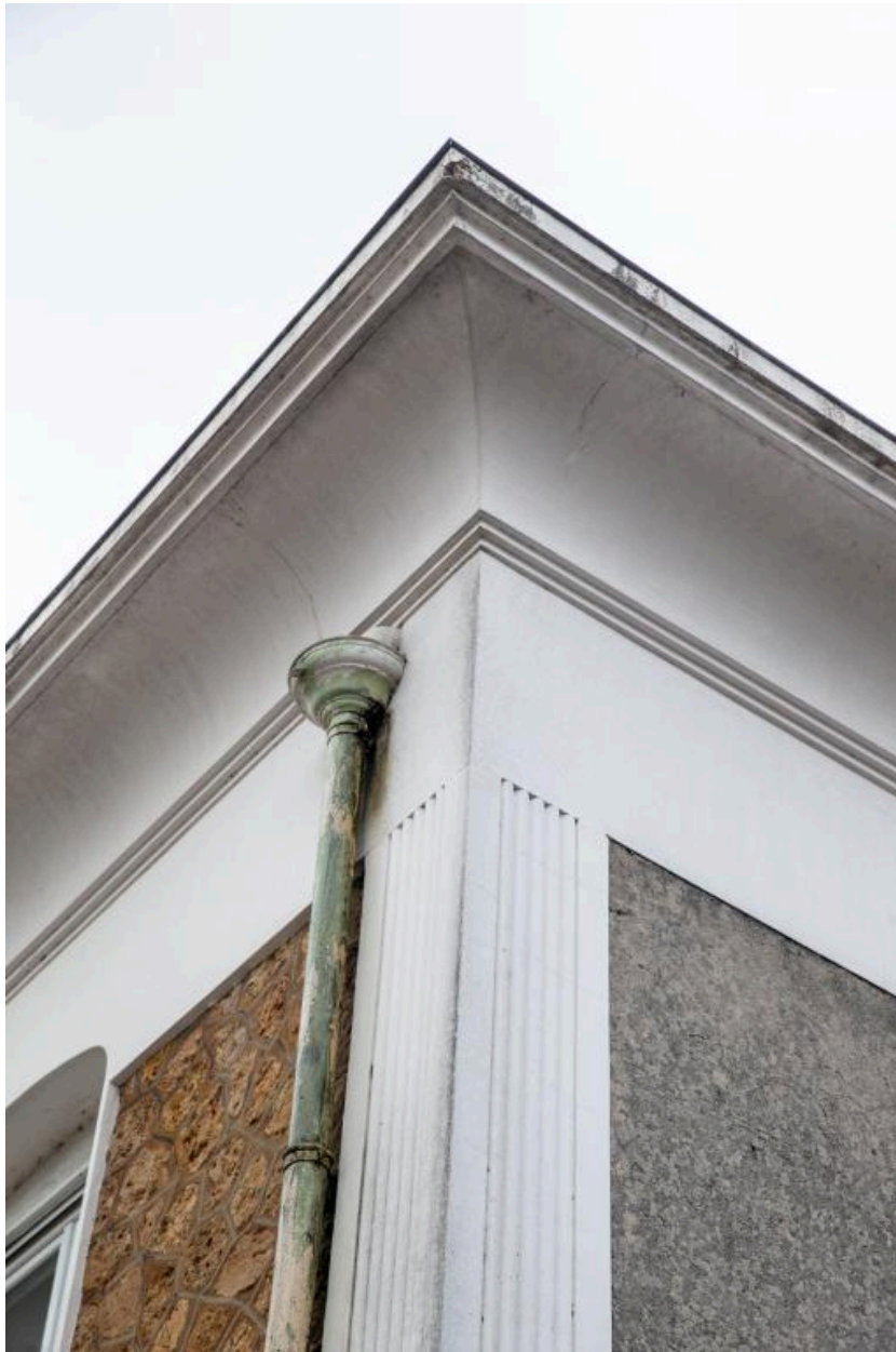
Un détail d'un pilastre d'angle et de la corniche.
