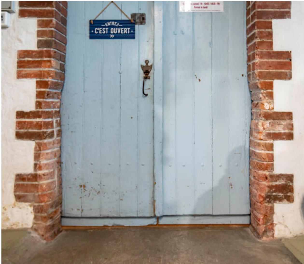
Détail de la partie basse de la porte d'entrée des magasins, élargie pour faciliter le passage des fûts.
