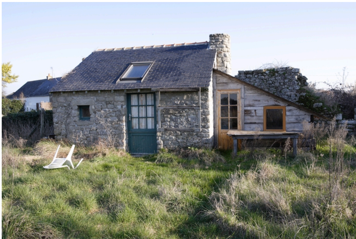
Vue du fournil depuis le sud.
