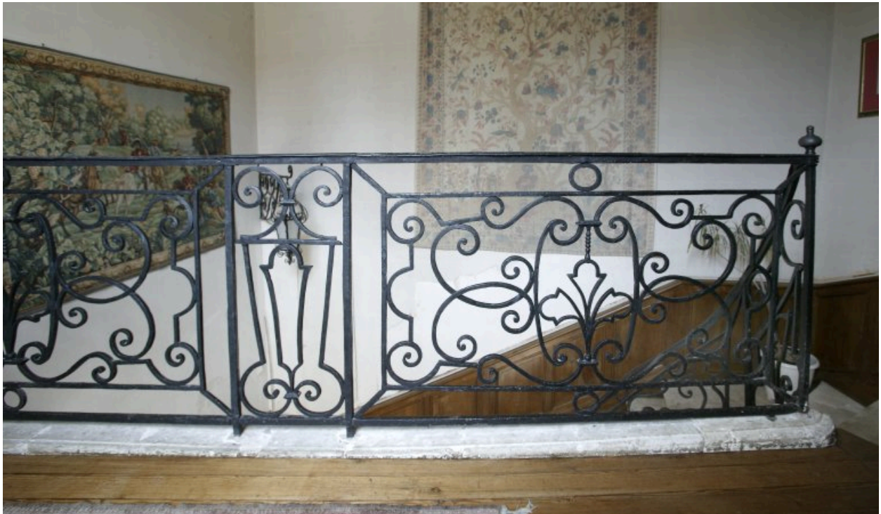
Détail du garde-corps de l'escalier.
