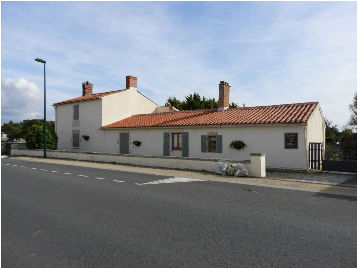
Maison en rez-de-chaussée, en partie surmontée d'un niveau supérieur, 6 rue Galerne.
