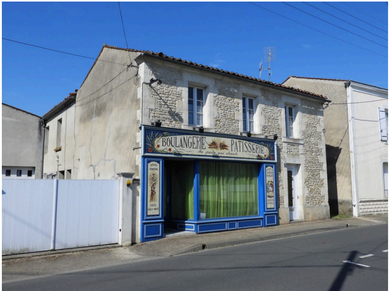
L'ancienne boulangerie vue depuis l'est.
