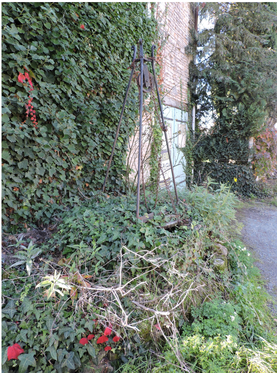
Le puits vu depuis le nord-est.
