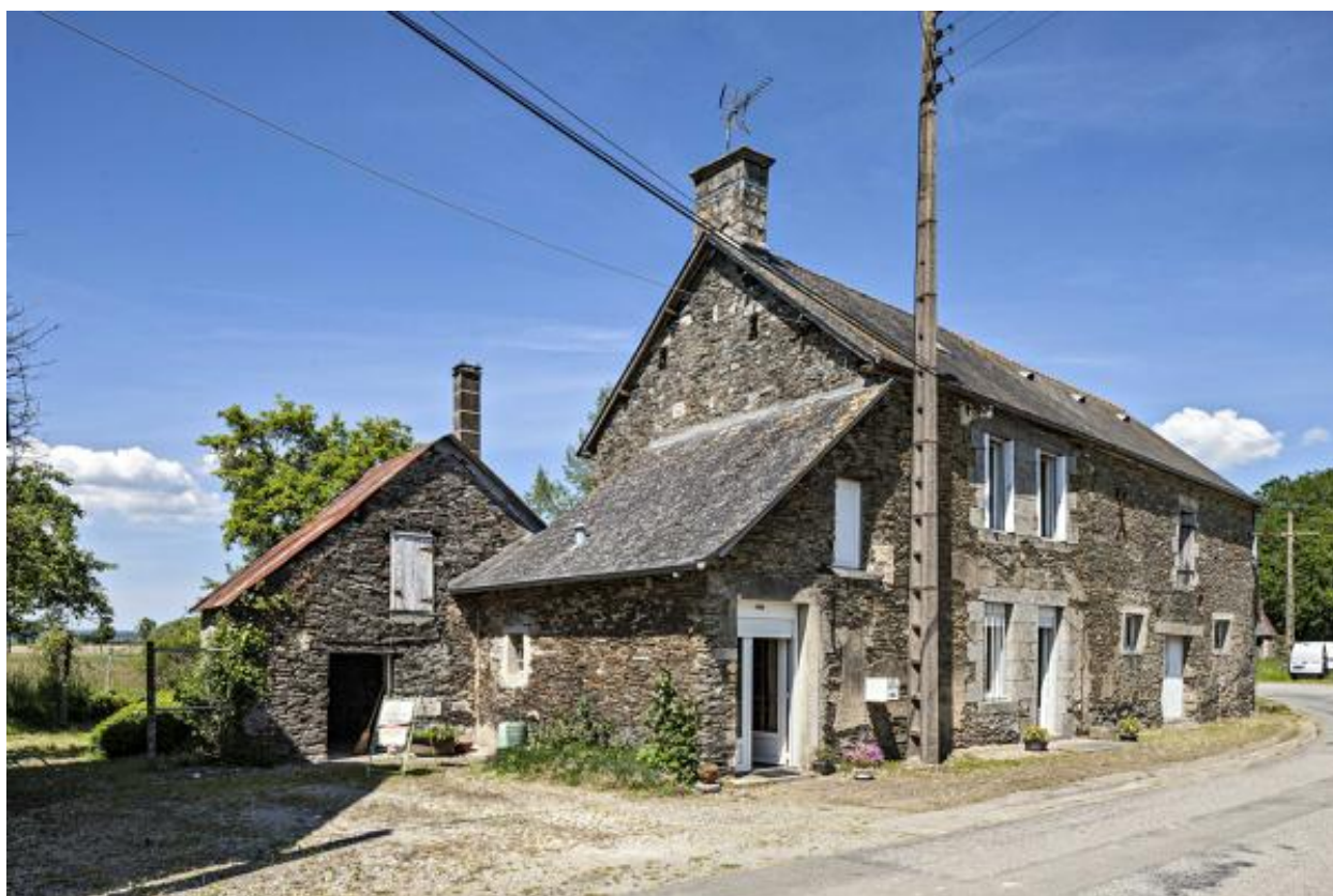
2 Bourgeray (2023 ZH 72), remise-fenil à l'arrière, maison et étable-grange
