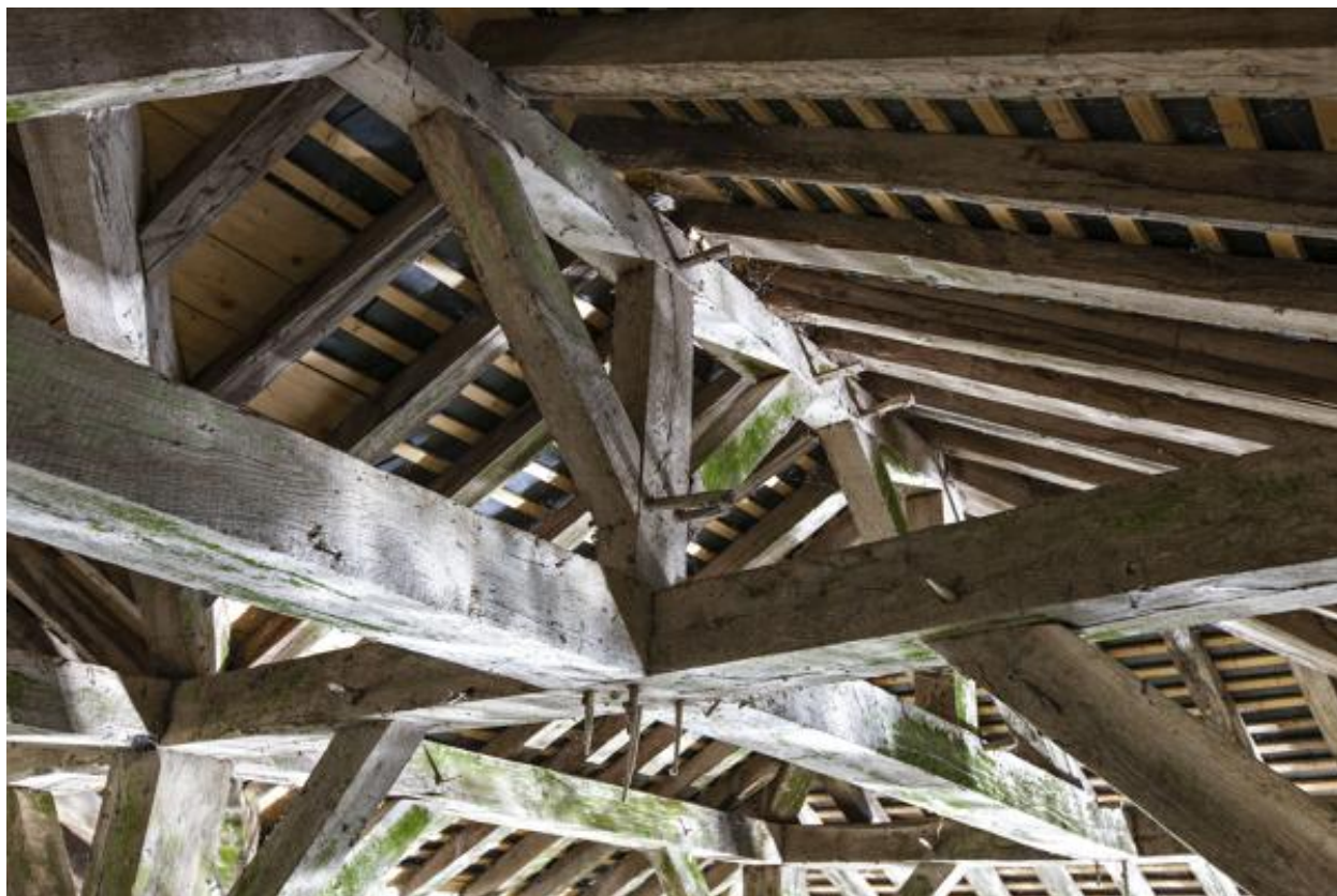
Charpente du lavoir de la Drouardière.
