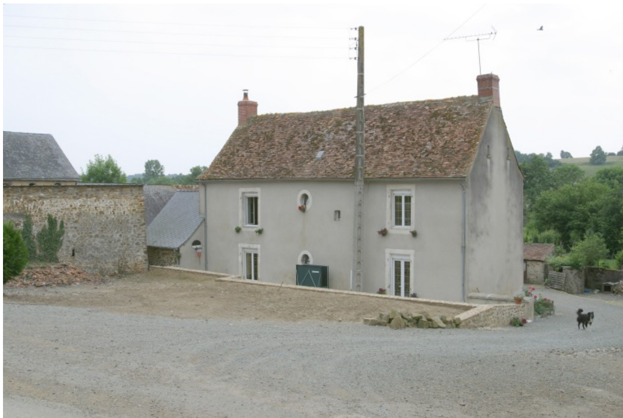
Première ferme, maison de maître : élévation postérieure vue depuis la route de Thorigné.
