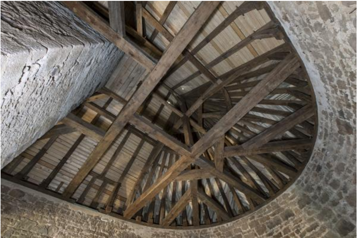
Charpente de la tour Lavoisier, restaurée.
