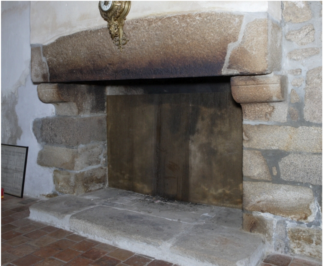
Logis. Rez-de-chaussée. Pignon est. Détail de la cheminée.
