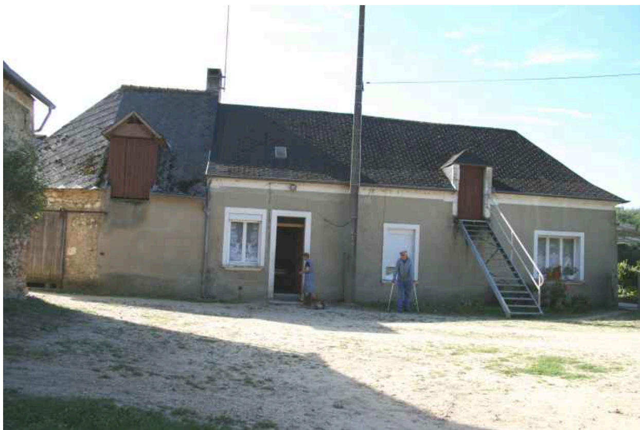
Maison 2 : façade antérieure.
