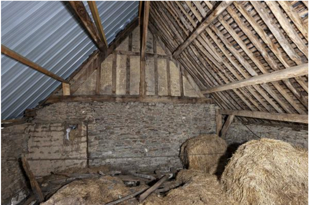
Ferme orientale, mur de refend entre le logis et l'étable-grange, vu depuis l'étable-grange.
