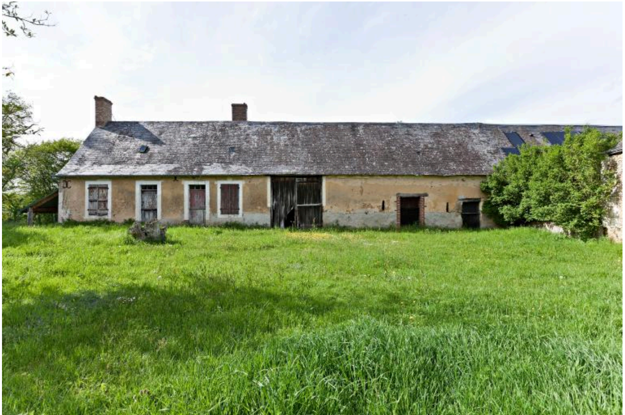
Ancienne métairie : maison et grange-étable, façade sur cour.
