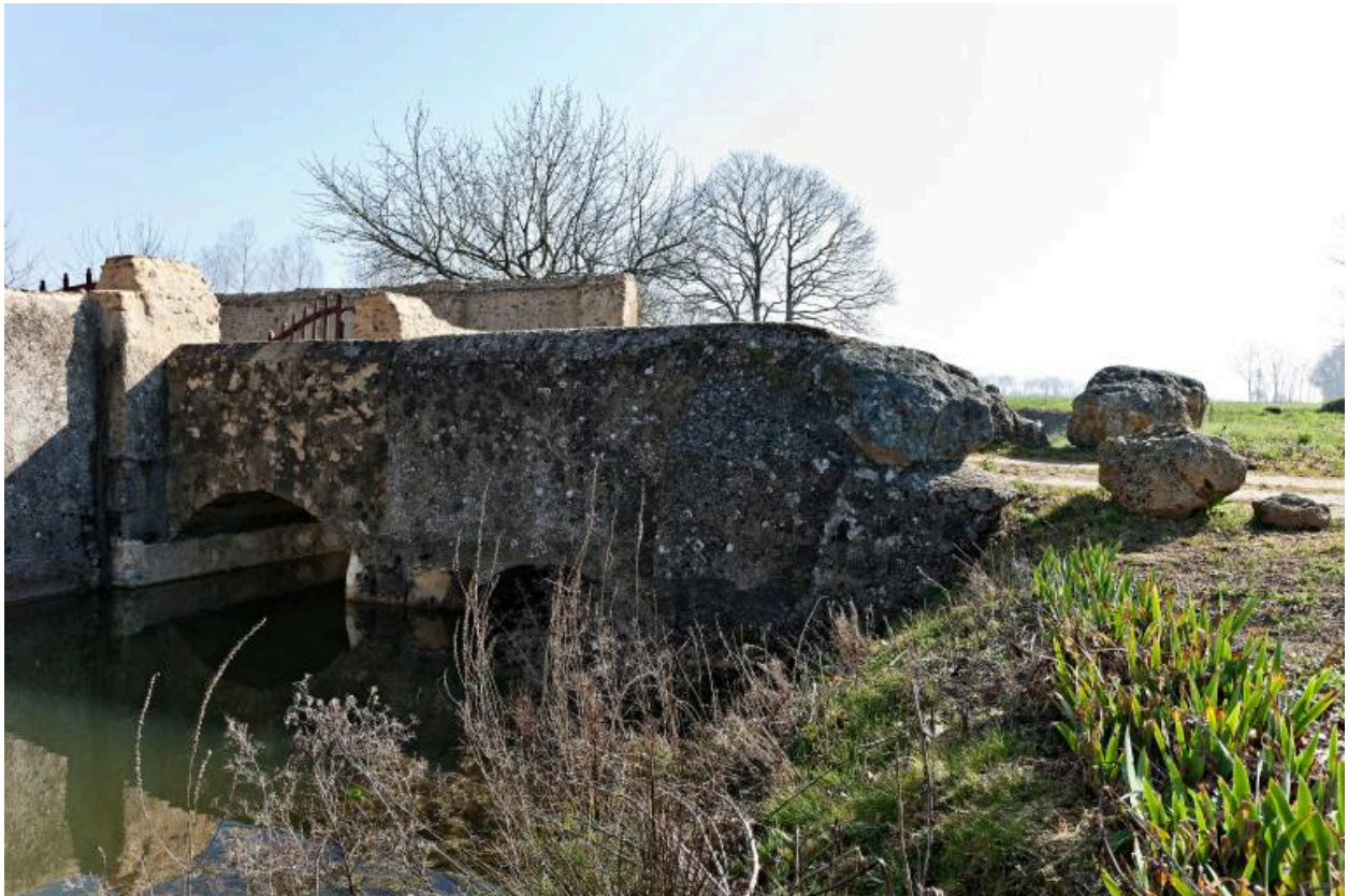
Pont d'accès à la cour centrale : face ouest.
