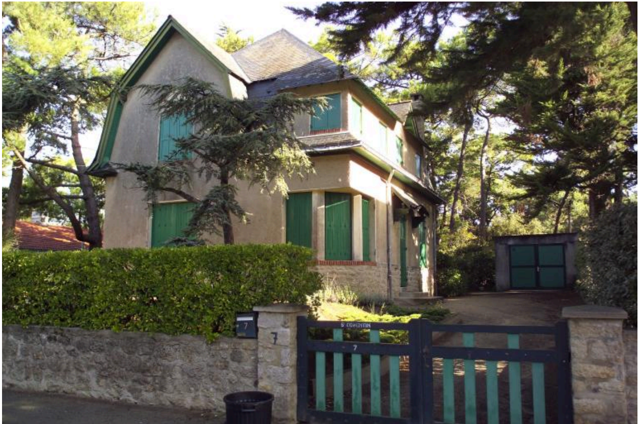
Vue d'ensemble de la villa Saint-Corentin.
