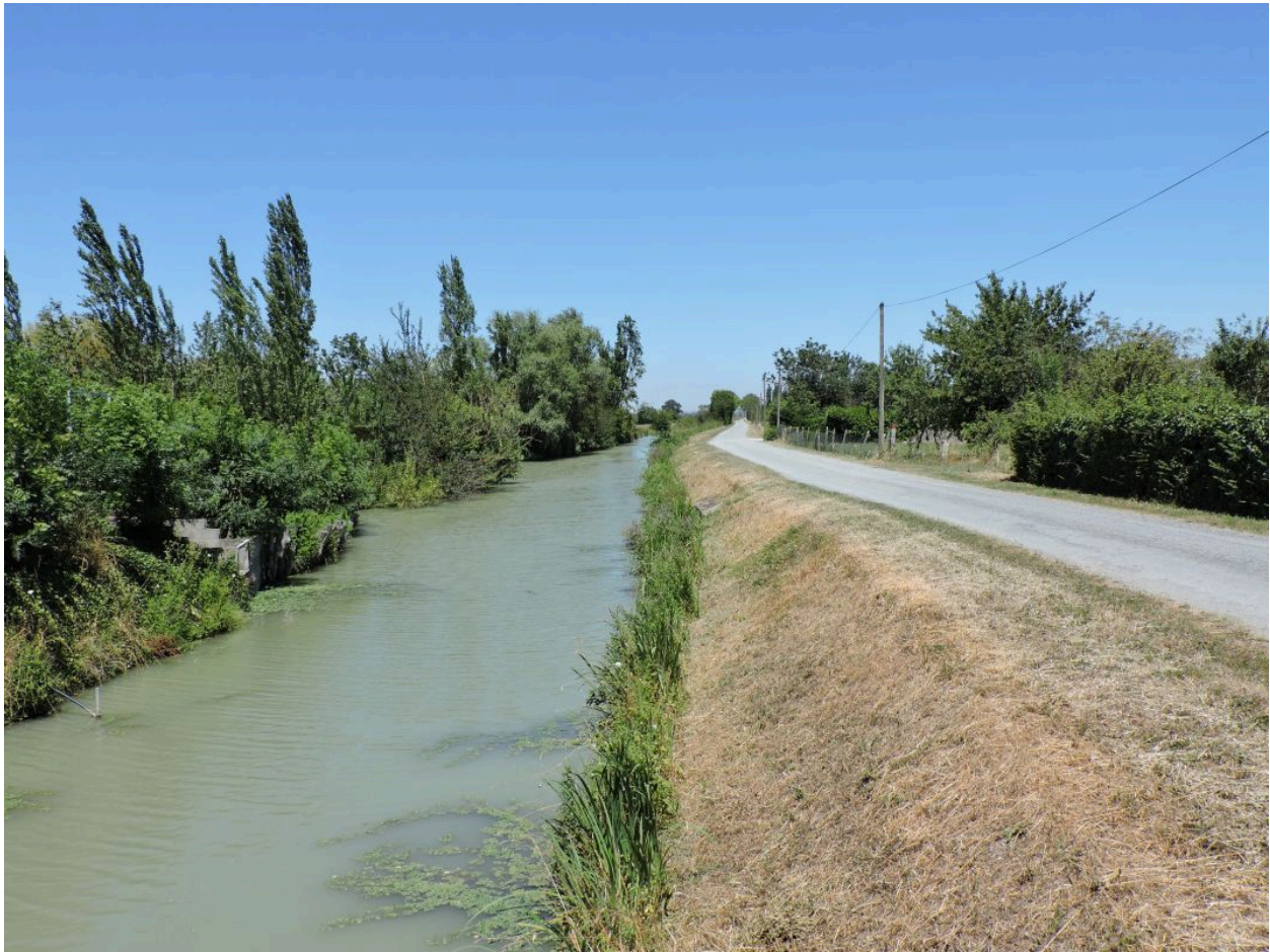
Le canal et son chemin de halage, vus depuis le sud, à l'entrée du village du Pont aux chèvres.
