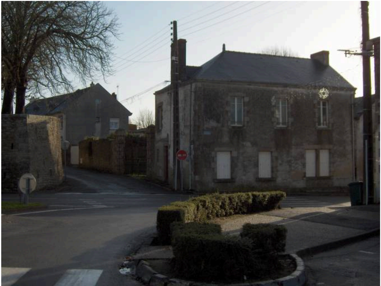
Vue de la maison de maître depuis le boulevard du Midi.
