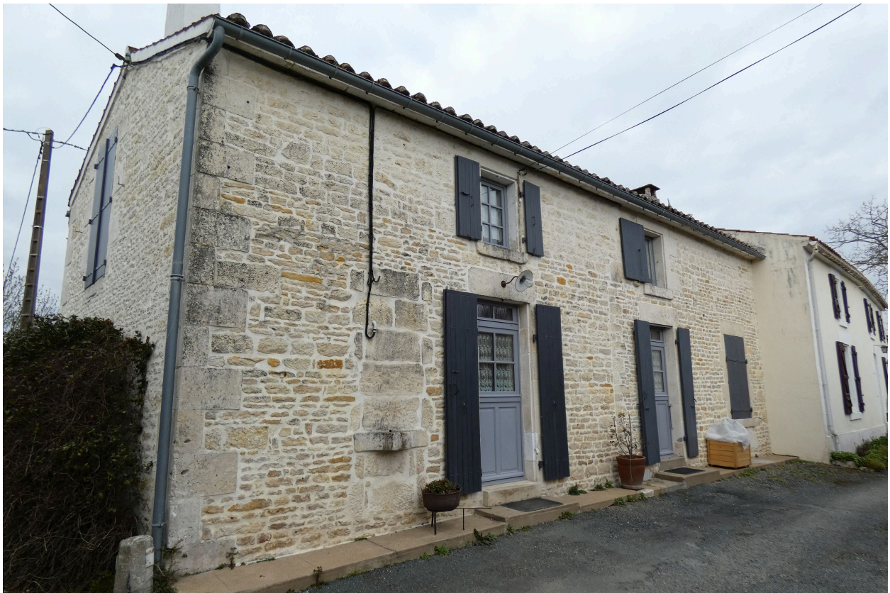
L'aile sud du logis vue depuis le sud-ouest.
