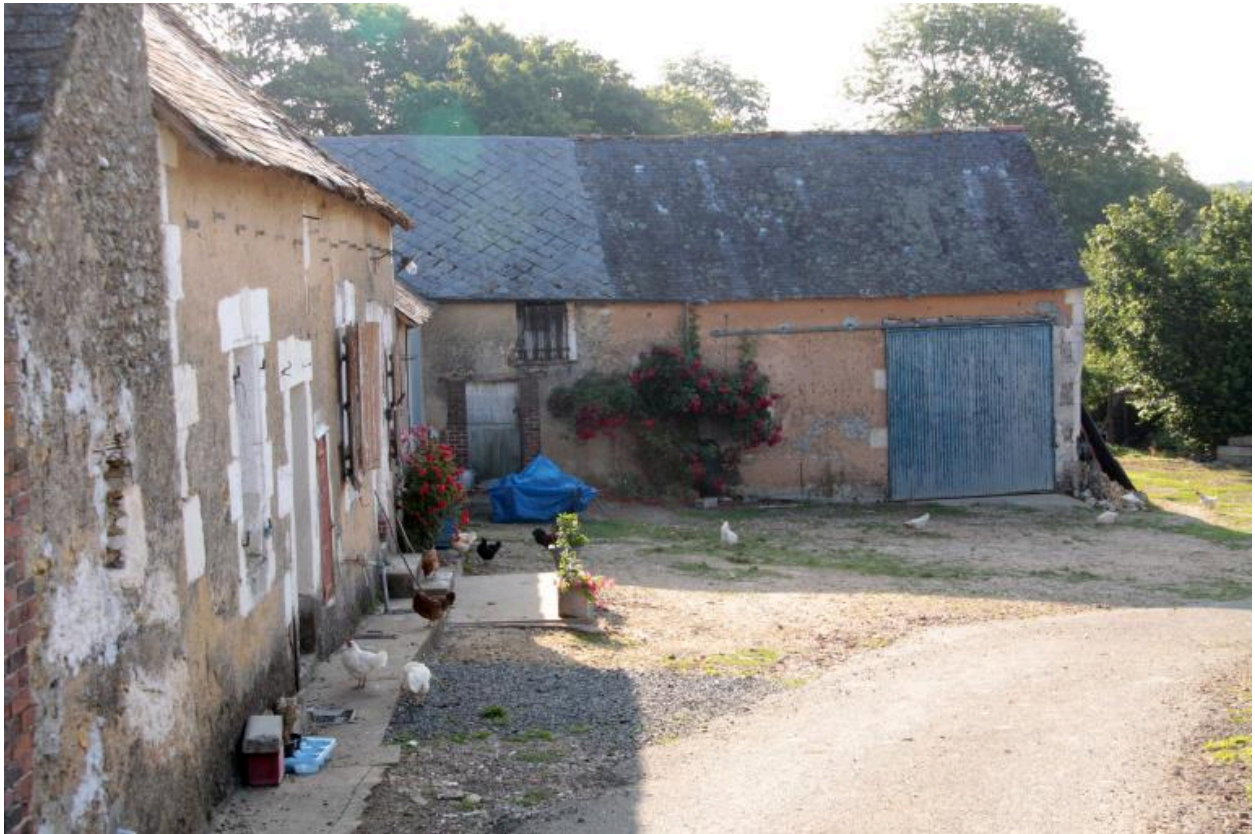
Etable et grange 2 : façade ouest sur cour.
