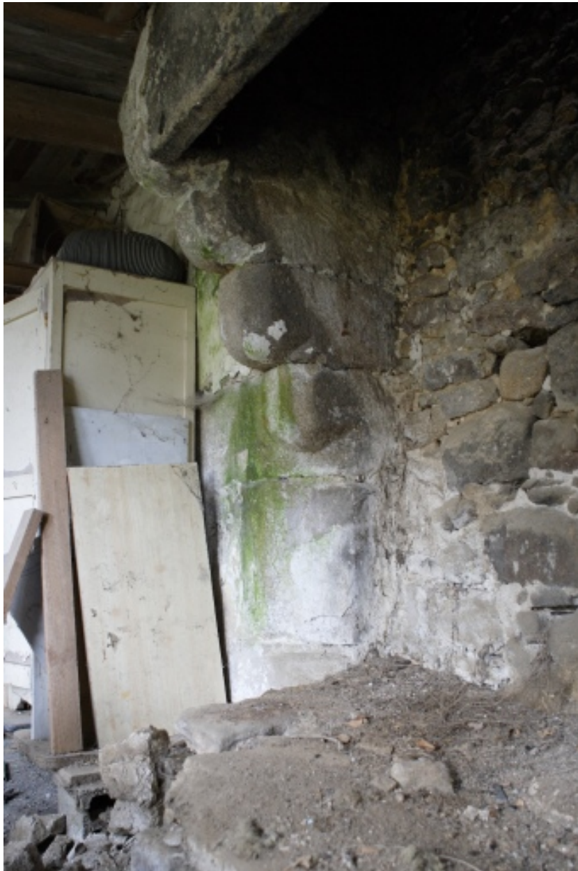
Détail des consoles en quart-de-rond chanfreiné de la cheminée est.
