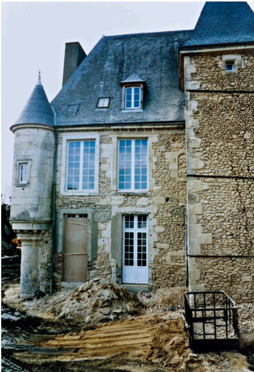
Logis, élévation sur cour : état pendant la restauration de 2008
