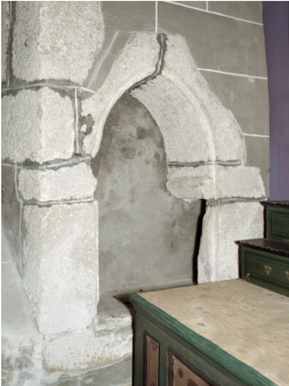
Détail d'une niche sur le mur goutteau nord.
