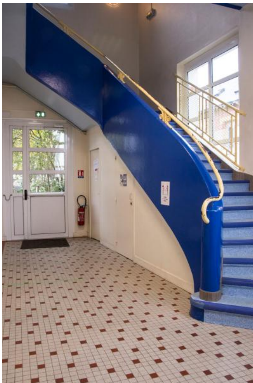
Vue de l'escalier depuis le rez-de-chaussée.
