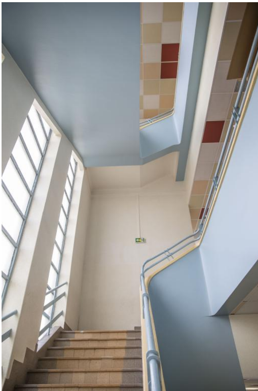
Vue de l'escalier tournant avec jour de l'aile gauche depuis le rez-de-chaussée.
