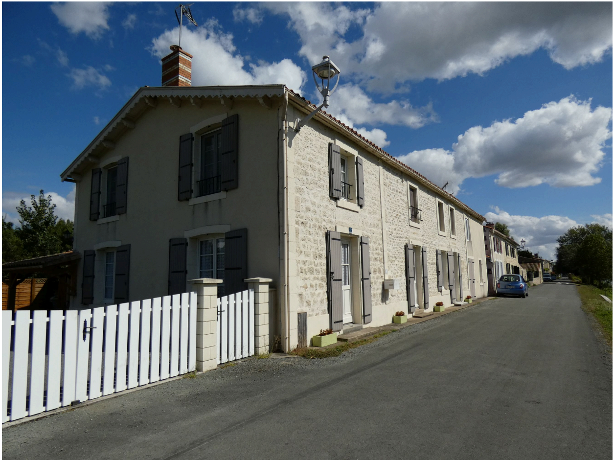
L'ancienne ferme vue depuis l'ouest.
