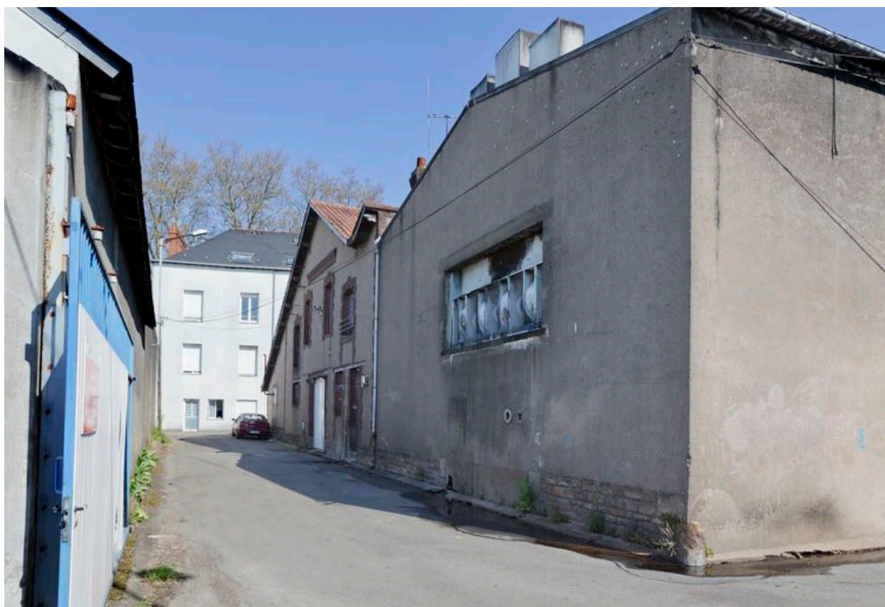
Rue des chantiers Crucy.
