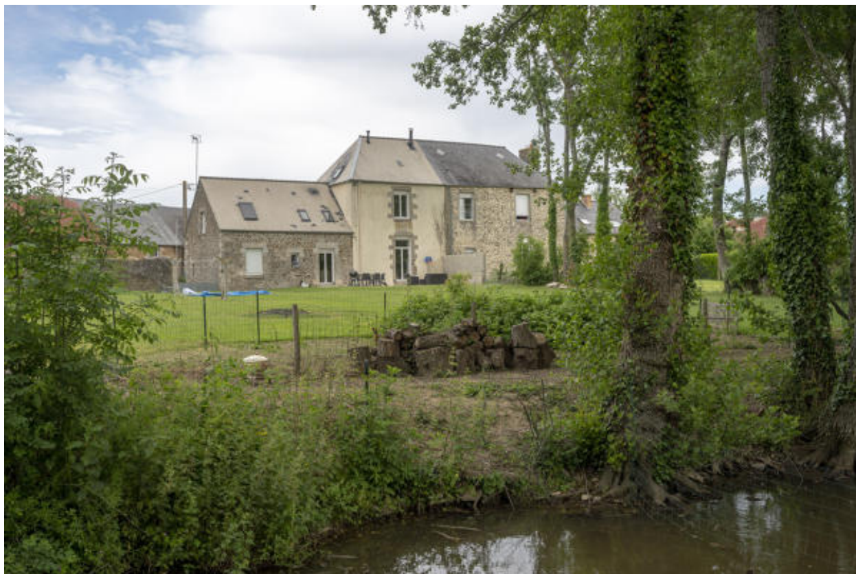
La façade postérieure de la maison, du côté de l'étang.
