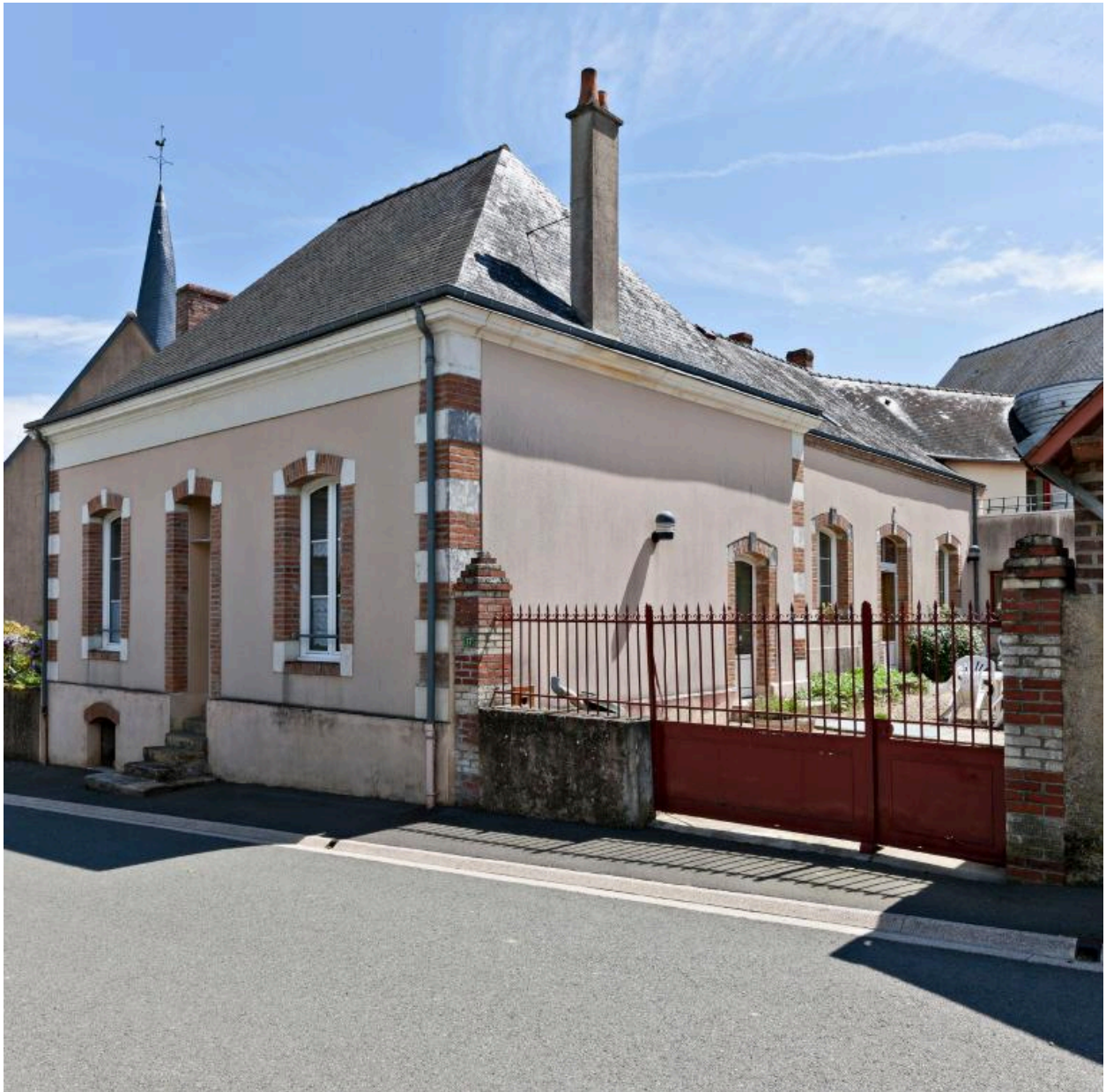
Ancien logement de l'instituteur et école, vus depuis la rue.
