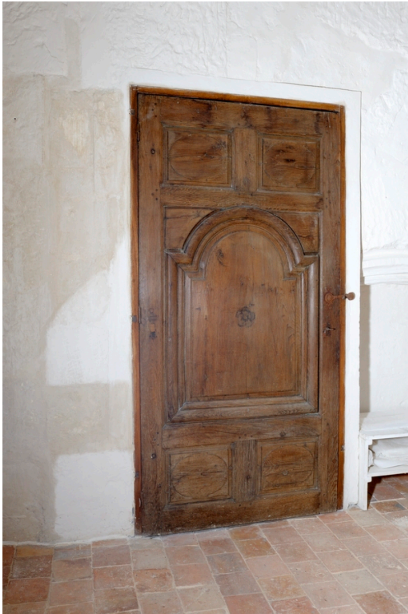
Ancienne chapelle nord (fin XVe siècle), étage. Porte (du 18e siècle, en remploi), condamnée, qui ouvrait sur le RdC du 13, place des Diligences.
