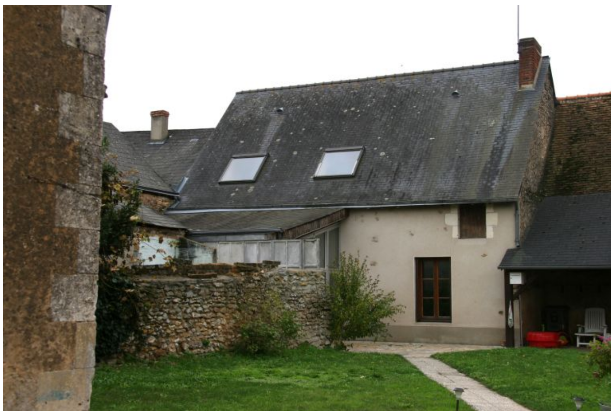
13, rue Principale, maison : façade postérieure.
