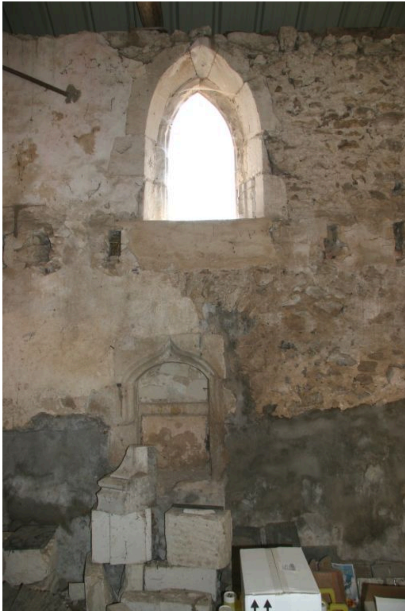
La chapelle : revers de la baie brisée sur cour.
