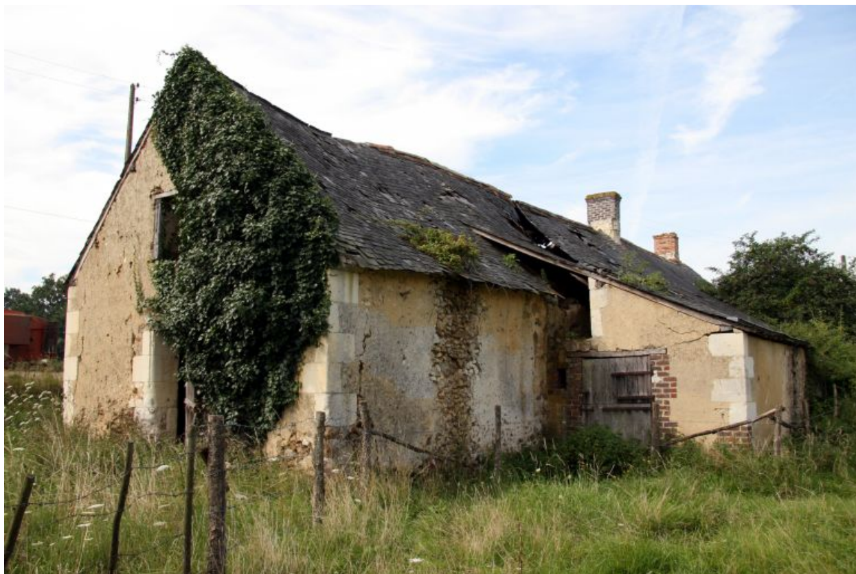
Vue de volume prise du nord-est : pignon est.
