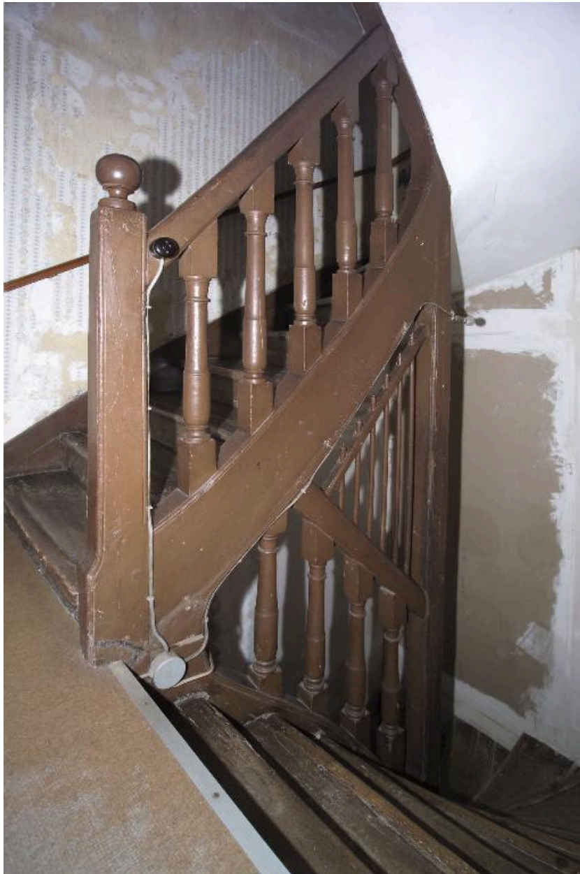
L'escalier depuis le palier du premier étage.
