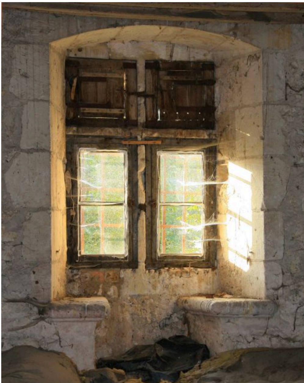
Bâtiment des greniers, 1er étage : croisée sud avec coussièges.
