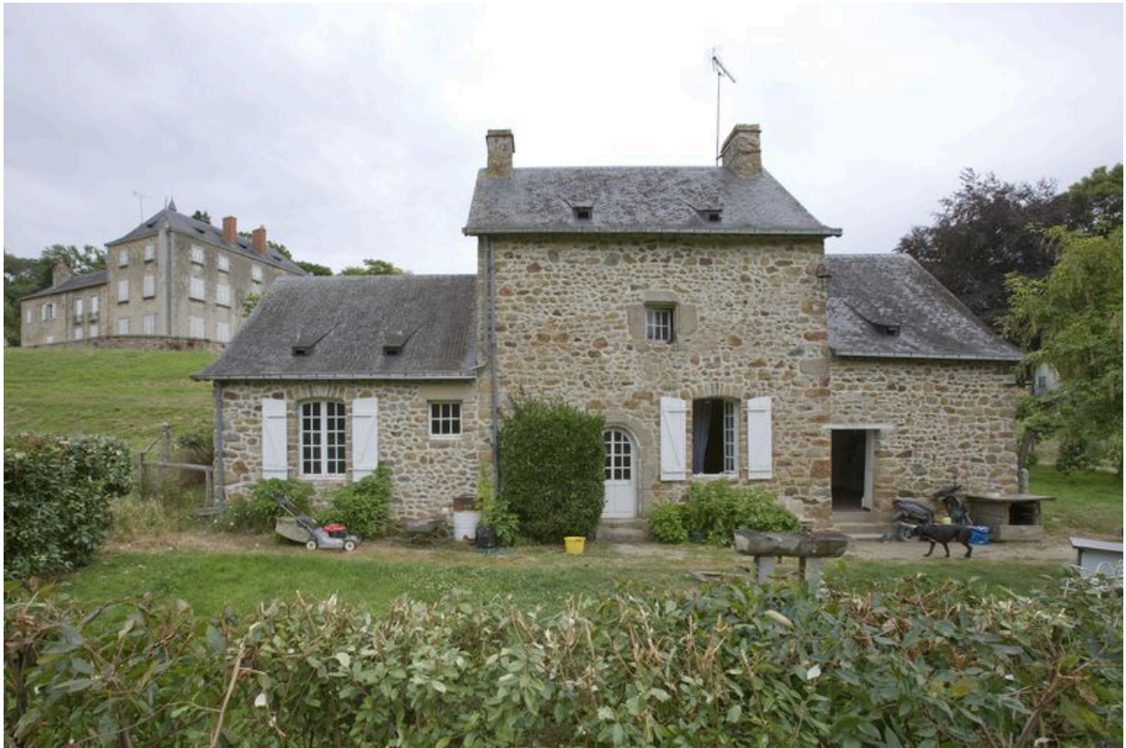
Le logis de métayer (?) : façade principale vue depuis le sud-ouest.
