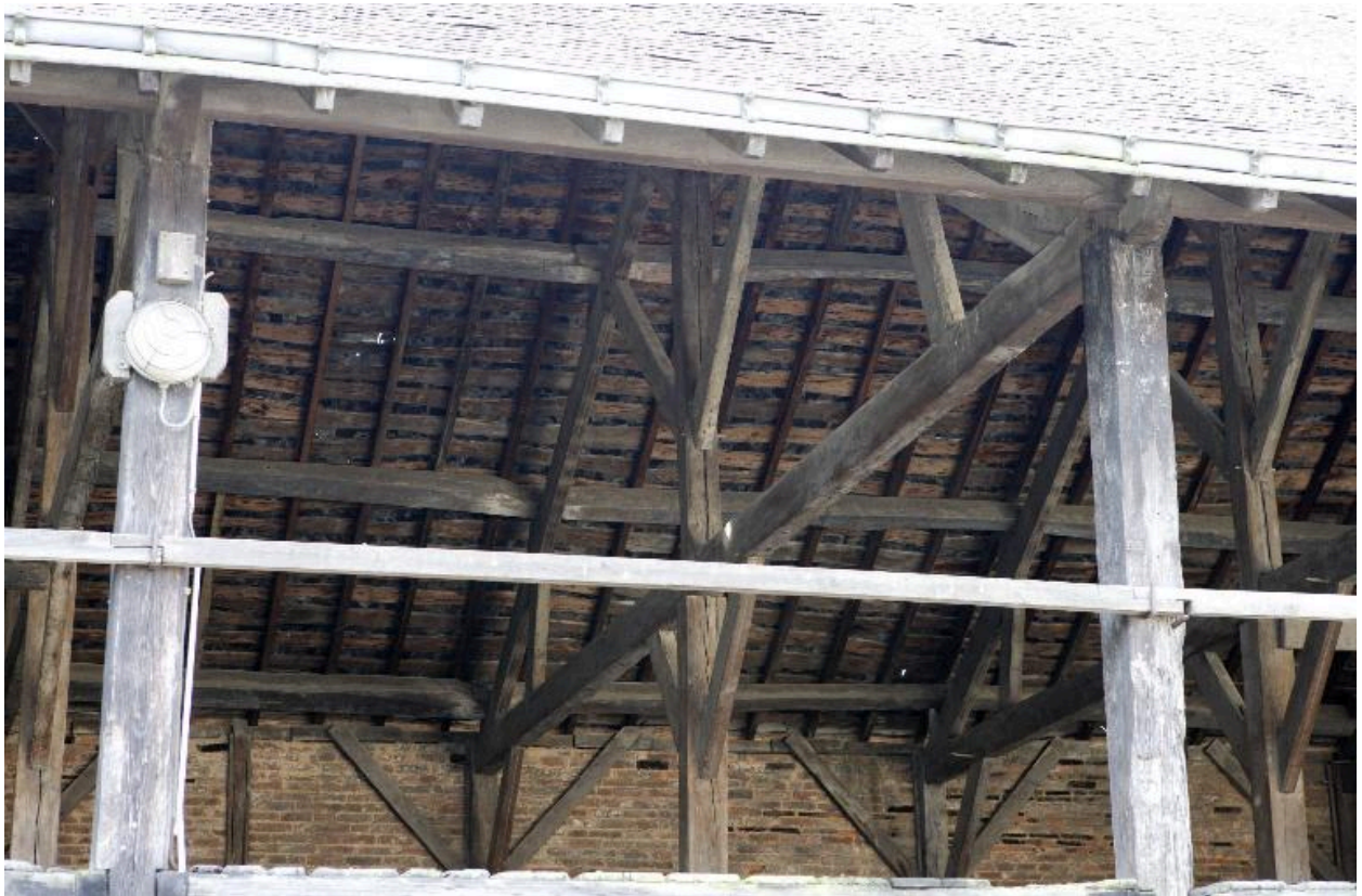
Ancienne tannerie du quartier Saint-Georges, détail de charpente.
