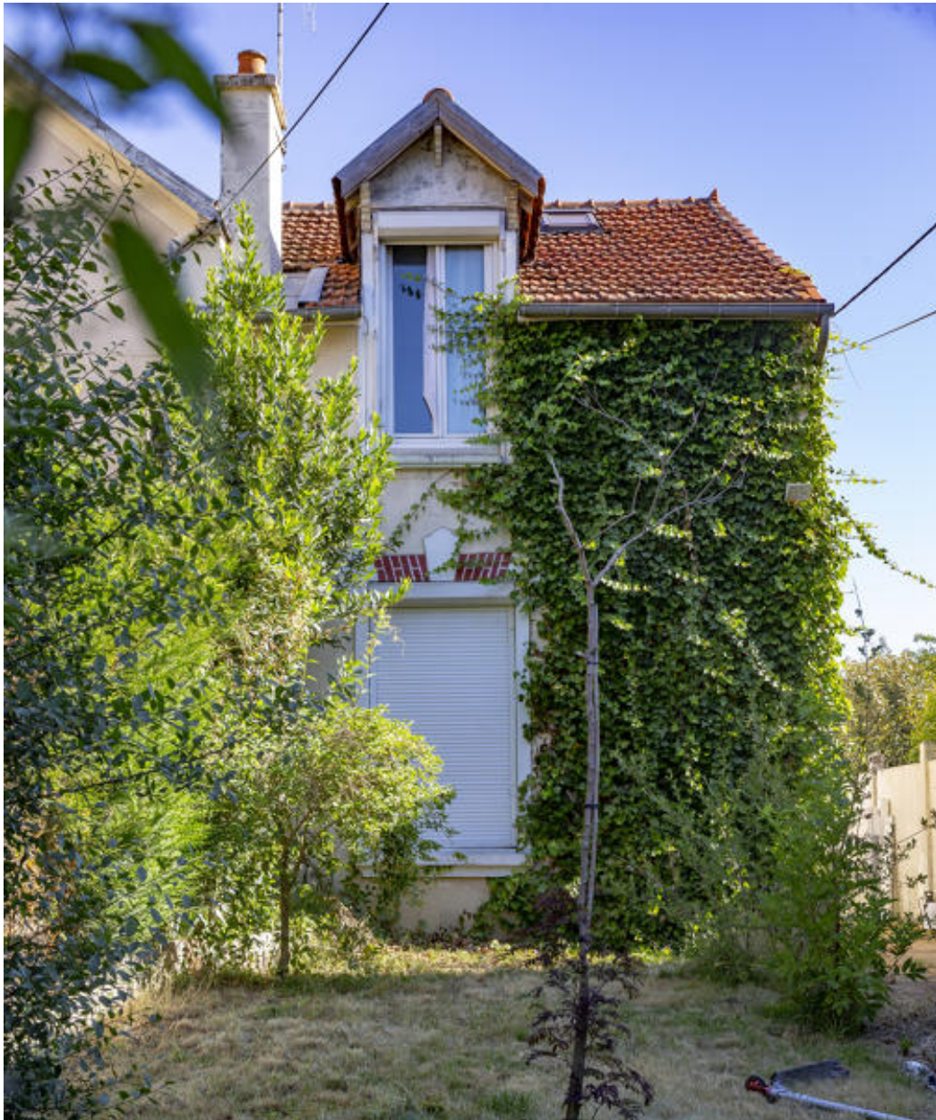
Vue d'une maison en retrait rue du Pavé.
